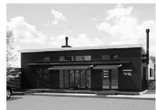
「Stufa Niigata」外観
