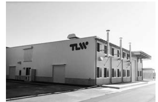
新設した第3工場
