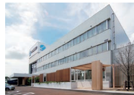
▲ツインバード工業(株)本社 設計者 (株)イトーキ (設計補助・施工)
